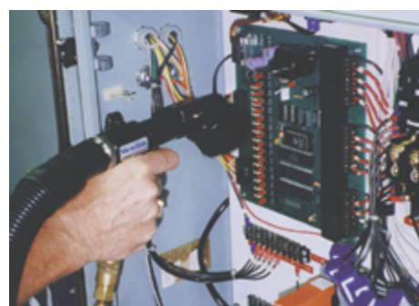
System pistoletu Vac-U Gun zbiera pył z czułych elementów elektronicznych.
